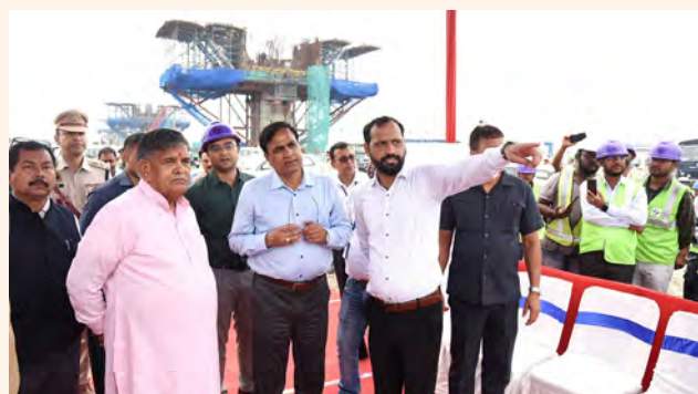
धुबड़ी-फुलबाड़ी पुल के निर्माण कार्य का जायजा लेते हुए।
